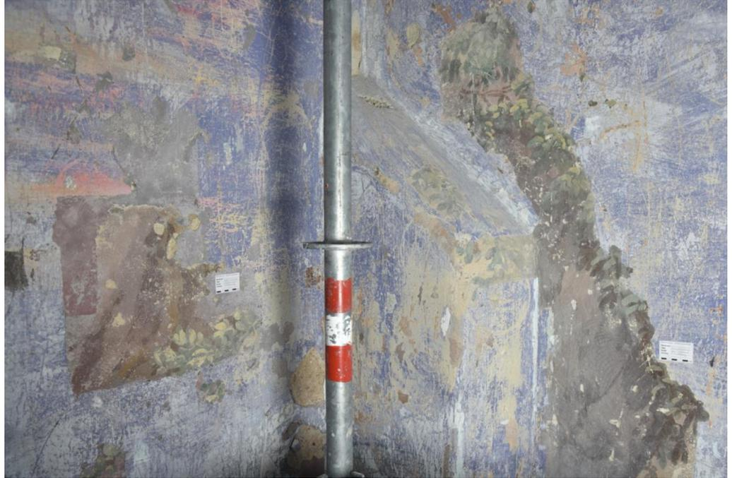
Die stellenweise sichtbaren Blattranken gehören der bauzeitlich ersten Fassung an. Die Darstellung ist gut erhalten, haftet entsprechend gut auf der Feinputzschicht, zeigt jedoch vereinzelt Schäden, die auf eine Putzentfestigung zurückzuführen sind. Auf Höhe des Gewölbebeginns bricht der Putz samt der Darstellung ab. Eine Freilegung und Restaurierung der Fassung wäre allein aufgrund dieser gegebenen Unvollständigkeit nicht empfehlenswert.
